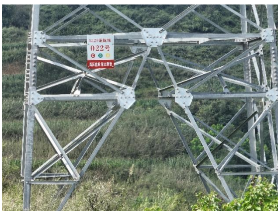
N22 塔基及施工临时场地绿化
