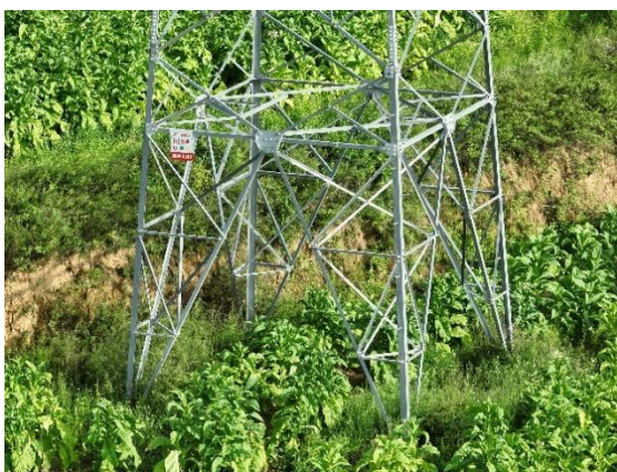
N18 塔基及施工临时场地绿化
