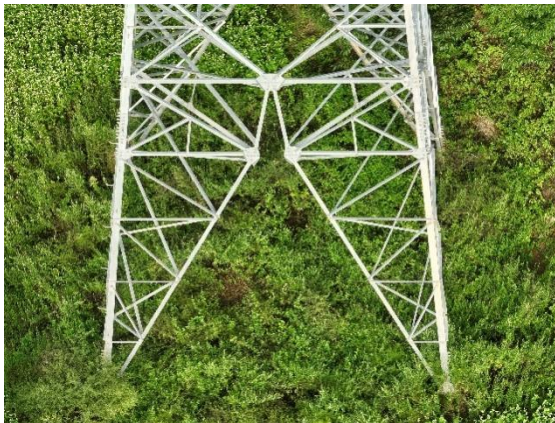
N16 塔基及施工临时场地绿化
