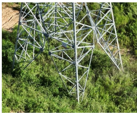
N4 塔基及施工临时场地绿化
