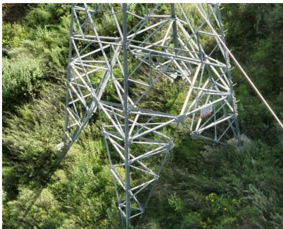
N14 塔基及施工临时场地绿化
