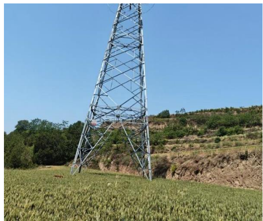
N15 塔基及施工临时场地绿化
