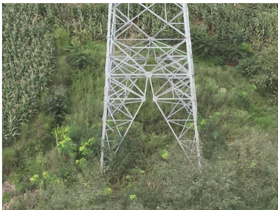
N25 塔基及施工临时场地绿化
