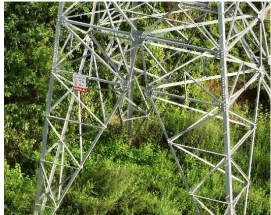
N17 塔基及施工临时场地绿化
