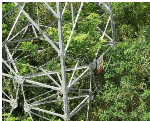
N28 塔基及施工临时场地绿化
