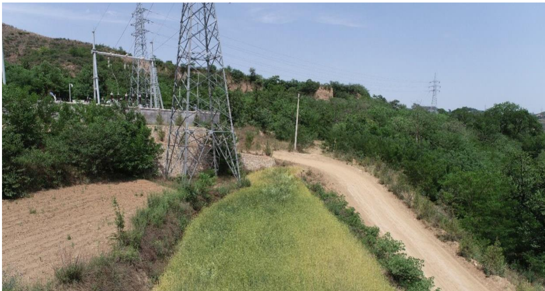
N1 塔基及施工临时场地现状
