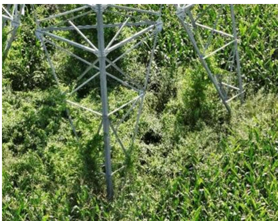
N8 塔基及施工临时场地绿化
