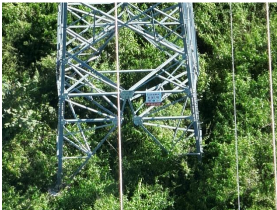
N5 塔基及施工临时场地绿化
