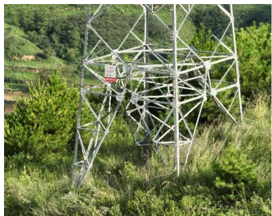
N19 塔基及施工临时场地绿化
