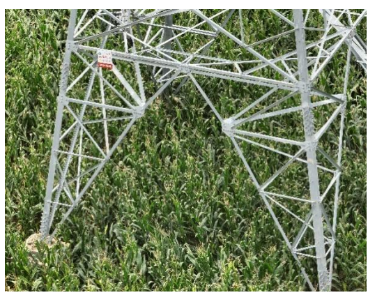
N33 塔基及施工临时场地绿化
