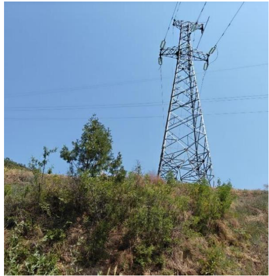
施工临时场地酸枣栽植
