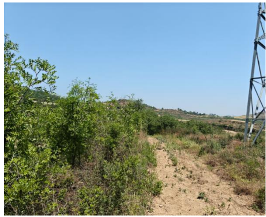
施工道路现状
