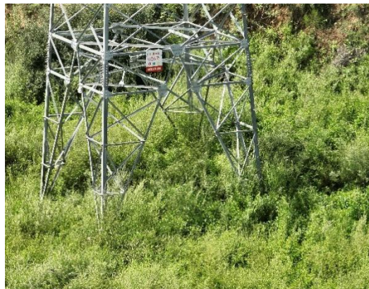
N26 塔基及施工临时场地绿化
