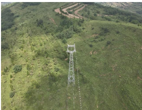
N29 塔基及施工临时场地绿化
