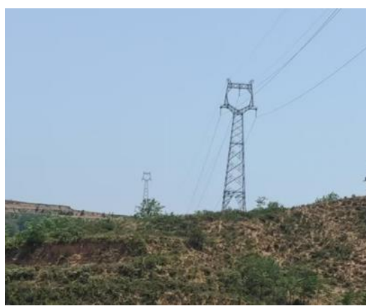
N11 塔基及施工临时场地绿化
