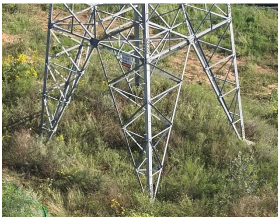
N3 塔基及施工临时场地绿化
