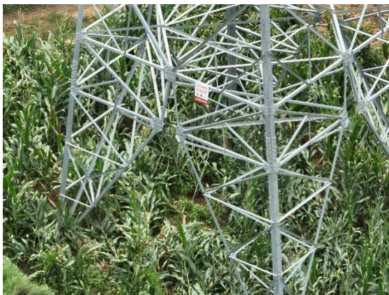
N32 塔基及施工临时场地绿化
