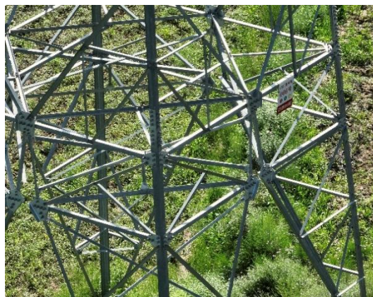
N6 塔基及施工临时场地绿化
