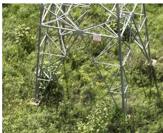
N30 塔基及施工临时场地绿化
